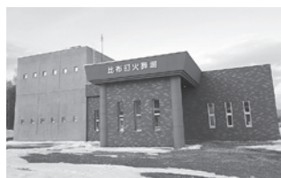
新しく建て替えられた火葬場
