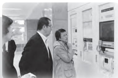
職員室には学校全体の防犯システムと電気・暖房などの機器操作盤を設置
