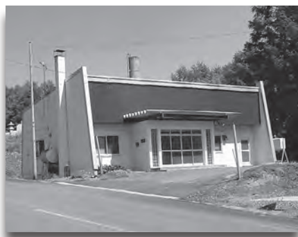
現在の町営火葬場施設
