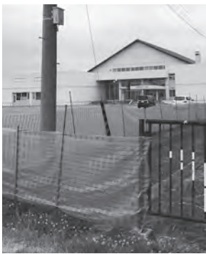
改善センター駐車場公園側 ネットフェンス
