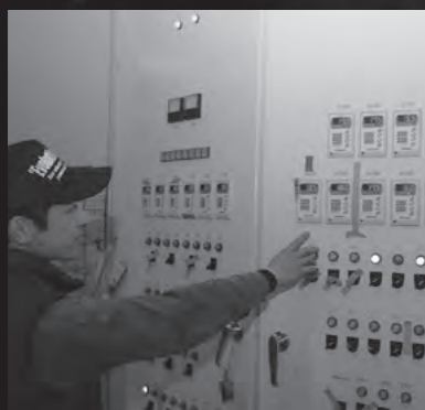
きのこを効率よく生育させるため、工場内の気温、湿度、換気など工場内の空調を徹底的に管理している。
