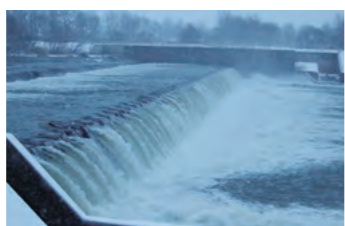
石狩川中流域にある「旧花園頭首工」
