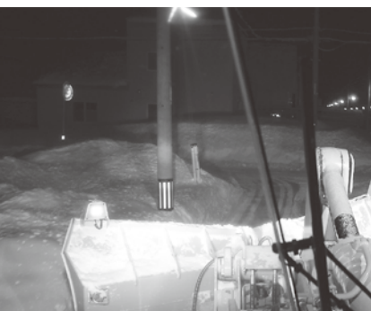
巧みなハンドルさばきで車両を操る作業員。住宅が立ち並ぶ市街地は、縁石や電柱などの障害物が多く、作業が難しい。
