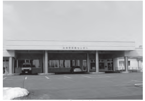
▲保健センター（平成2年築）
