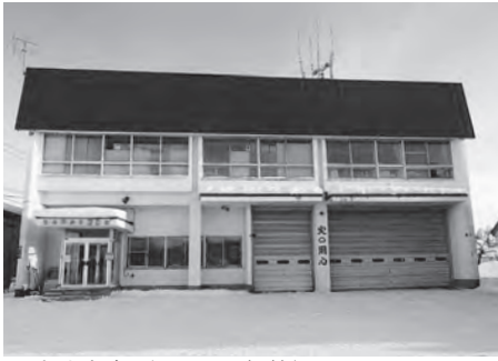
▲消防庁舎（昭和44年築）
